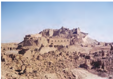
ج) ارگ بم بعد از زلزله
