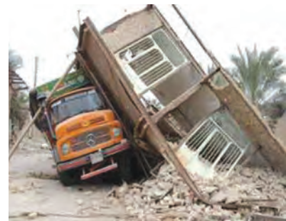
الف) ریزش دیوار در اثر زلزله
