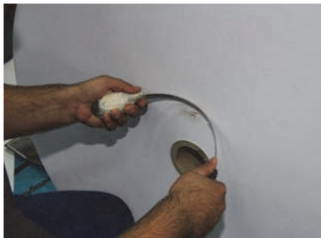
شکل ۵- برطرف کردن آسیب روی بدنه رول
