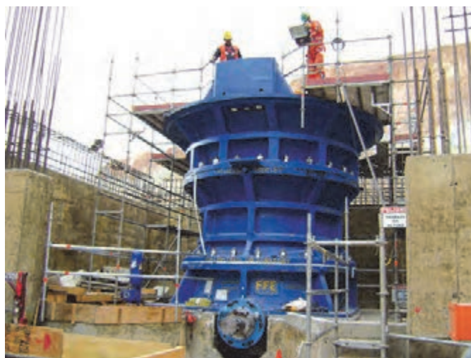
دستگاه سنگ شکن ژیراتوری در حال نصب بر روی فونداسیون
