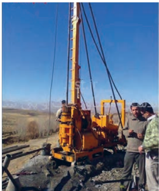
دستگاه حفاری مستقر شده بر روی فونداسیون
