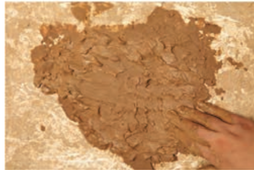
شکل ۱۰- تهیهٔ گل یکنواخت با دوغاب
