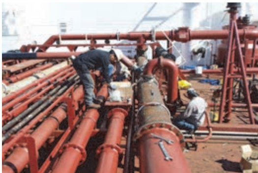
شکل ۷- در حال اجرای لوله‌کشی کشتی
