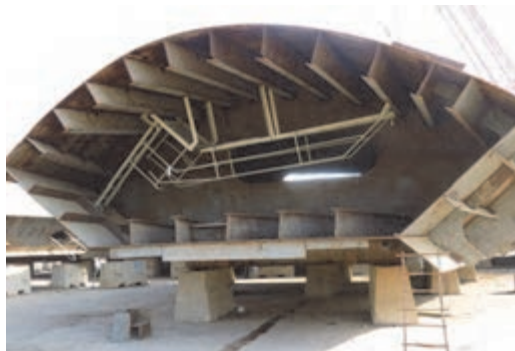
شکل ۶- اتمام جوش کاری بلوک کشتی
