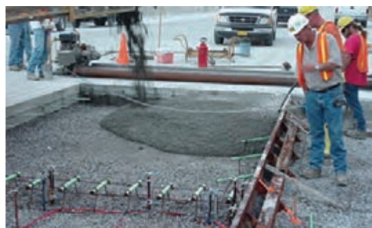
اجرای روسازی بتنی با استفاده از قالب‌بندی
