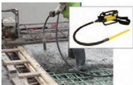
تراکم بتن تازه با دستگاه ویبره
