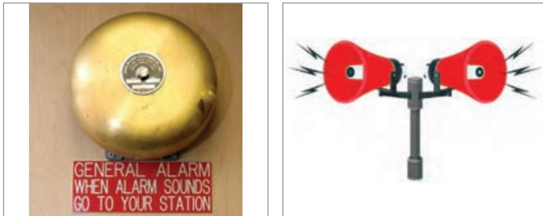
شکل ۱۳- سیستم اخطار شناور
