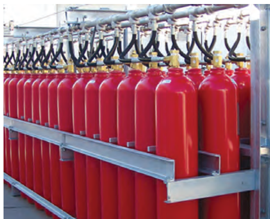
شکل ۳۸- سامانه اطفای حریق CO 2
