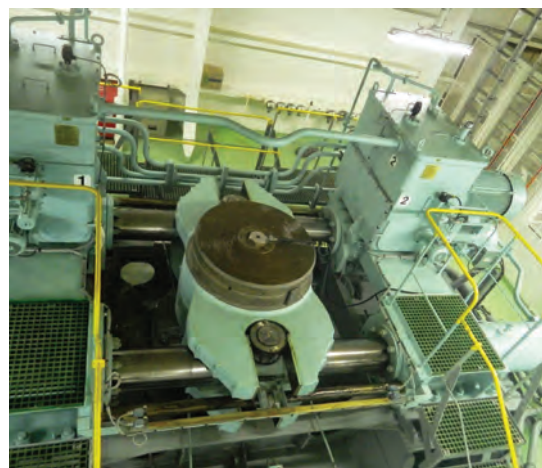
شکل ۳۷- تجهیزات اتاق سکان
