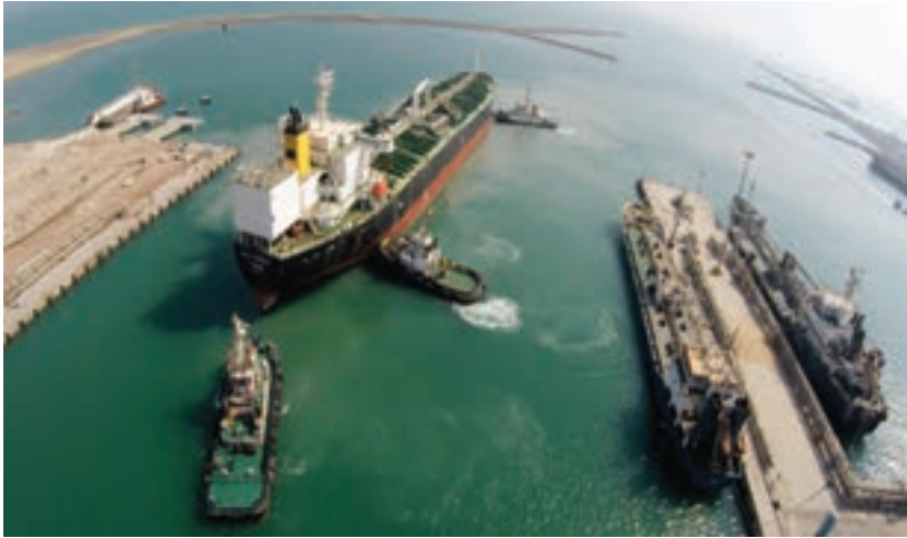
شکل ۲۰- عملیات پهلو دهی کشتی به اسکله
