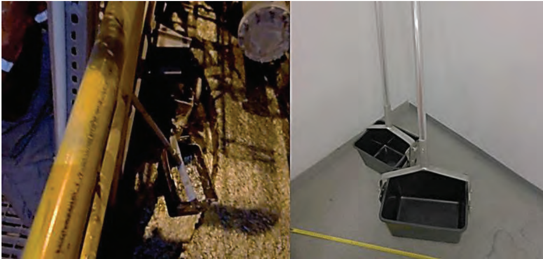
شکل ۳۴- تجهیزات نمونه‌گیری از سرریز سلول فلوتاسیون
