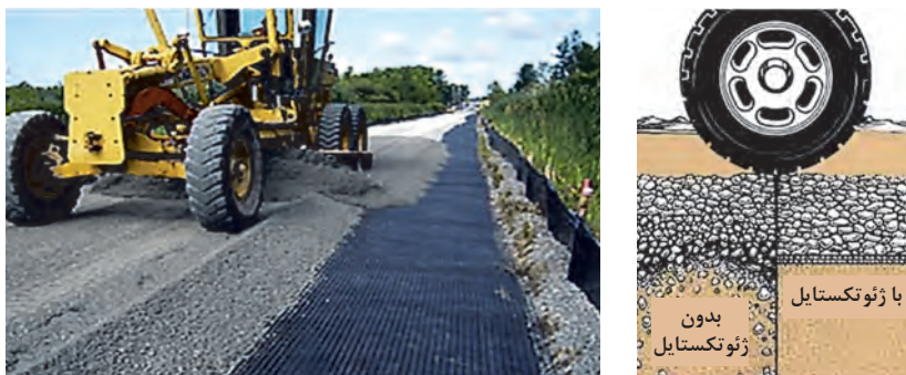
شکل ۲۵- کاربرد پارچه‌های ژئوتکستایل در زیرسازی راه
