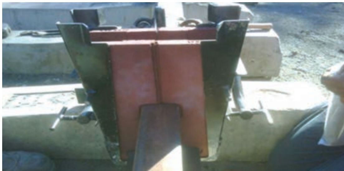
شکل ۱۸- نصب قالب اطراف ناحیه اتصال
