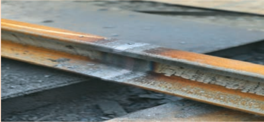
شکل ۳- ریل راه آهن که توسط جوشکاری ترمیت تعمیر شده است.
