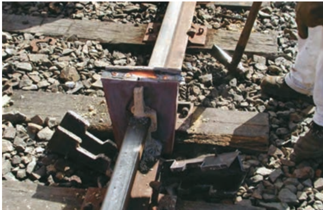
شکل ۲۵- باز کردن گیره و حفاظ قالب
