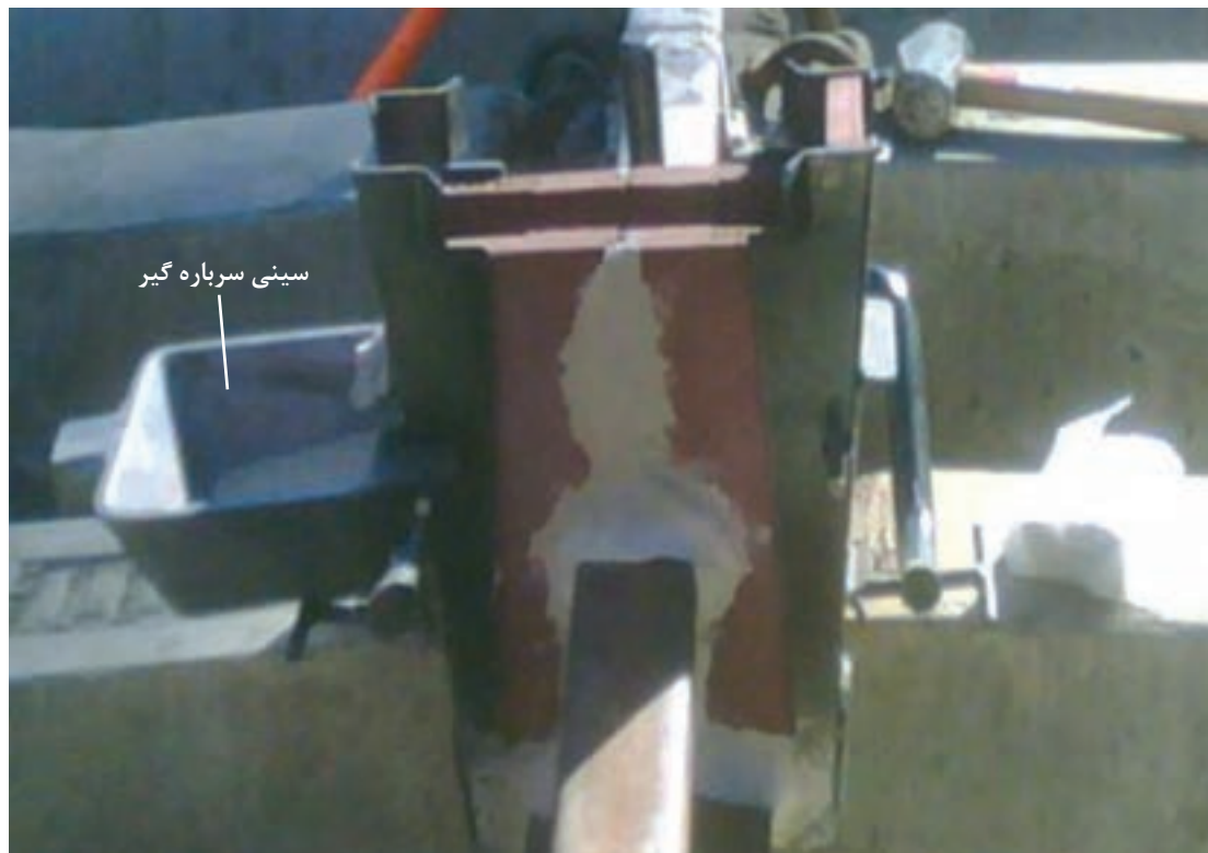
شکل ۲۰- نصب سینی‌های سرباره گیر
