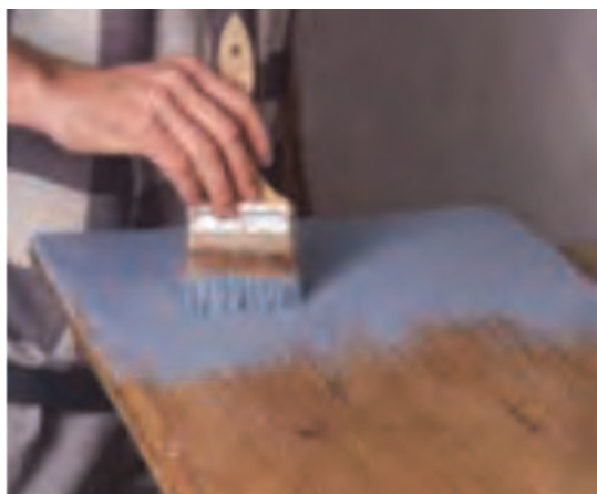
شکل ۲۱- زدن آستری یا قلم مو
