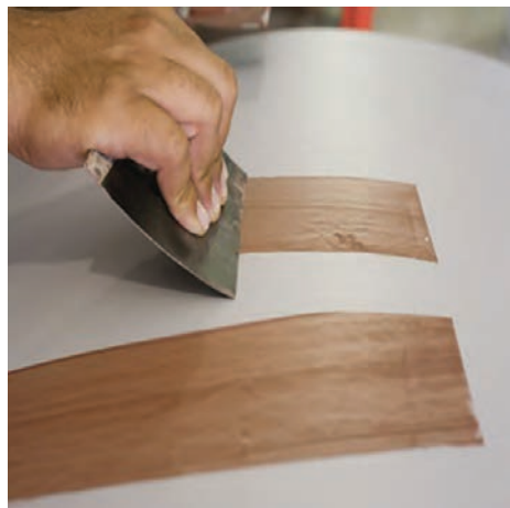
شکل ۲۶- ماستیک‌کاری
