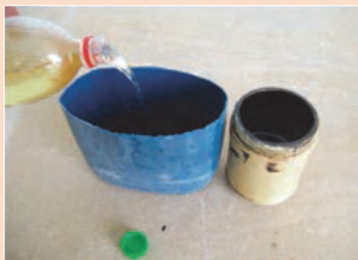
شکل ۸- اضافه کردن نفت به آستری قیری
