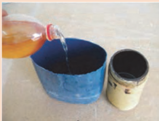
شکل ۷- رقیق کردن آستری قیری با بنزین
