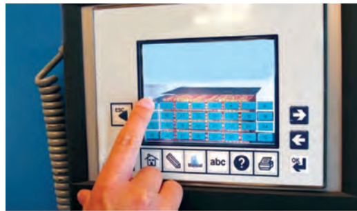
شکل ۵۱- تنظیم کنترل کننده
