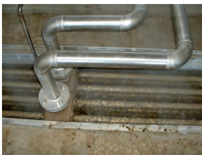
شکل ۶۱- کویل‌های حرارتی برای گرم کردن هوای کوره
