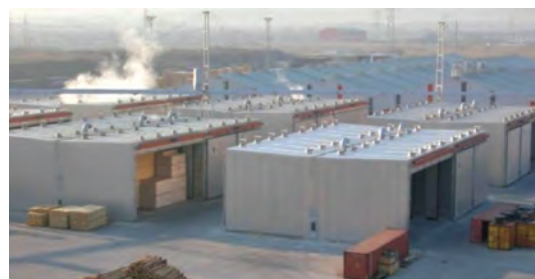
شکل ۲۹- کوره‌های چوب خشک‌کنی ساخته شده با آلومینیوم
