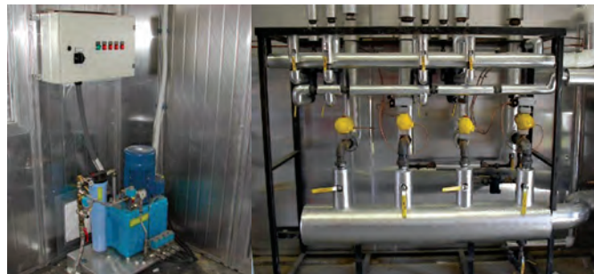
شکل ۶۰- شیرهای کنترل بخارزنی
