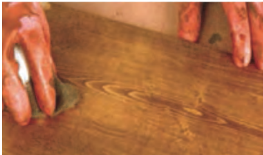
شکل ۱۴۴- زدن آستری هم رنگی با پارچه
