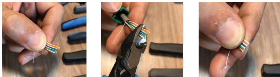
شکل ۲۷- مرتب کردن سیم‌های رنگی مطابق استاندارد
