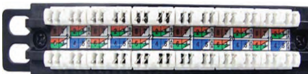
شکل ۵۵ - دو نمونه از رنگ‌بندی پیچ پنل
