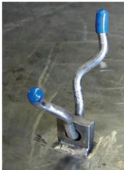
شکل ۳۸- نمونه‌ای از انکر نوع V آماده برای نصب دیرگداز بی شکل
