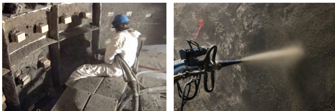
شکل ۲۸- نصب جرم با روش پاشش
