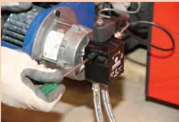
هواگیری پمپ
