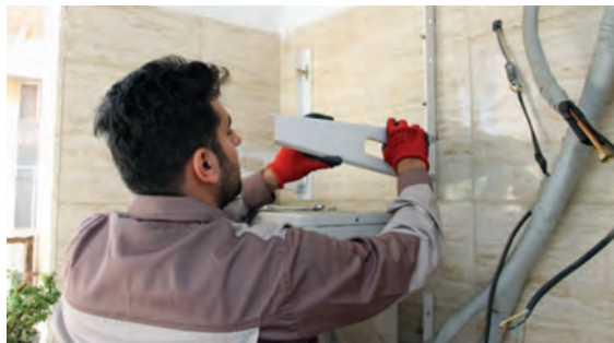
شکل ۷- نصب یونیت خارجی
