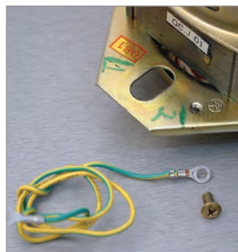
شکل ۳-۱۵ اتصال سیم ارت به بدنه دستگاه‌ها و دوشاخه
