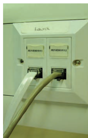
شکل ۲۶-۳- تصویر ظاهری و شمای فنی پریز تلفن
