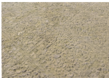
شکل ۲-۱۰۵- یزد، باغ دولت آباد، آژیانه
