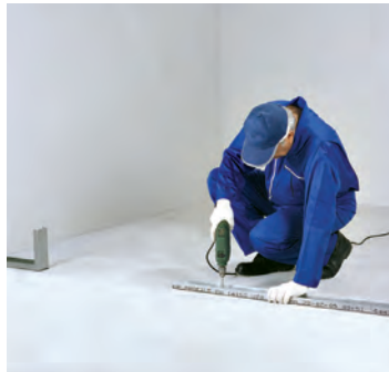
شکل ۱۱۴-۱- نصب رانر کف
