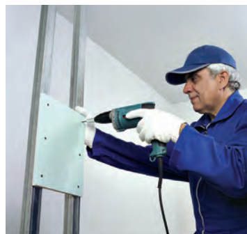
شکل ۹۷-۱- استادهای ردیف اول و دوم به وسیله برش‌هایی از پانل به یکدیگر وصل می‌شوند.
