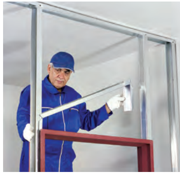
شکل ۱۲۹-۱- استقرار رانر نعل درگاه
