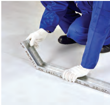
شکل ۱۱۵-۱- خم کردن انتهای رانر کف
