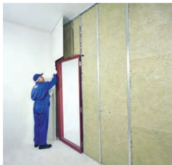
شکل ۱-۱۴۱- اجرای پانل سوم دور چهارچوب پس از عایق‌گذاری (پانل‌ها نسبت به سمت اول به شکل حصیرچین اجرا می‌شوند).
