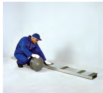
شکل ۸۱-۱- اجرای نوار عایق بر روی استاداها
