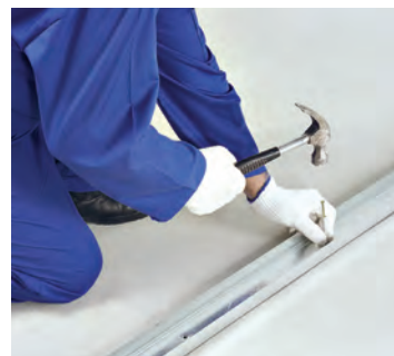
شکل ۴۲-۱- اتصال رانر به کف با رول پلاک
