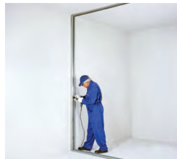
شکل ۱-۵۲-۱- نصب استاد بر روی ساختار جانبی
