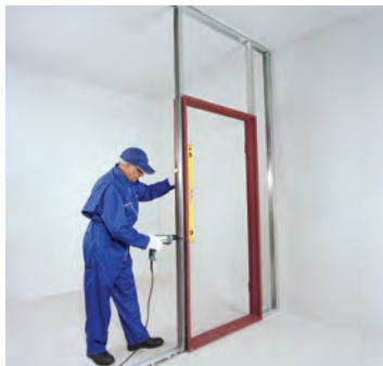
شکل ۱۲۲- اتصال بالای استاد با پیچ LB شکل ۱۲۳- اتصال چهارچوب به استاد شکل ۱۲۴- اتصال چهارچوب به استاد اول دوم
