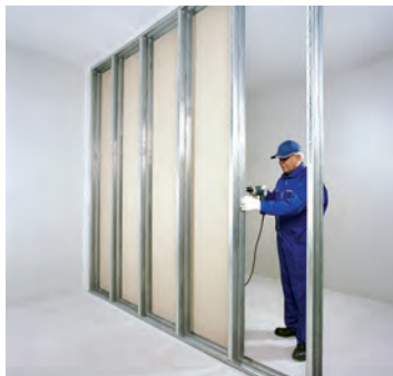
شکل ۸۶-۱- اجرای پانل‌ها در یک طرف دیوار
