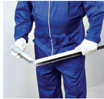
شکل ۱۲۸-۱- خم کردن انتهای رانر نعل درگاه
