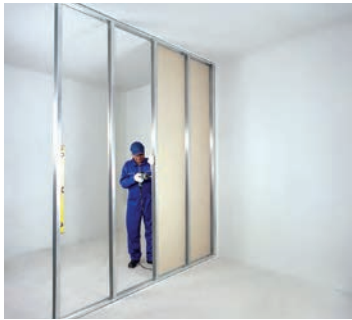
شکل ۱-۶۲- اجرای پانل‌ها در یک طرف دیوار
