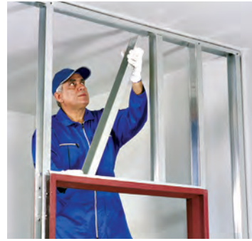
شکل ۱۳۱-۱- استقرار استادهای کتیبه
