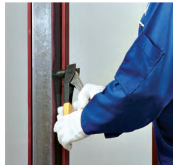
شکل ۱-۱۳۴- رانر تقویتی توسط پرچ به استاد متصل می‌شود.
