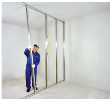
شکل ۸۳-۱- اجرای ردیف اول استاداها (به صورت شاقولی)
