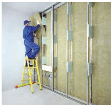
شکل ۹۹-۱- اجرای عایق معدنی
