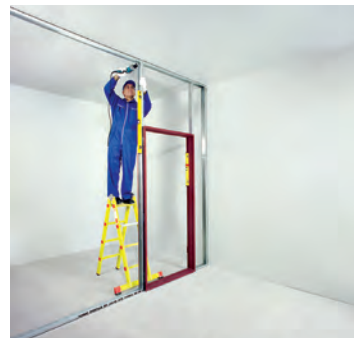
شکل ۱۲۲- اتصال بالای استاد با پیچ LB شکل ۱۲۳- اتصال چهارچوب به استاد شکل ۱۲۴- اتصال چهارچوب به استاد اول دوم
