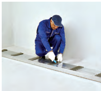
شکل ۸۲-۱- برش نوارهای عایق
