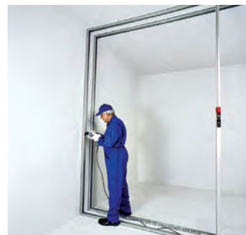
شکل ۱-۹۴- دو ردیف قاب با فاصله از یکدیگر اجرا می‌شود
