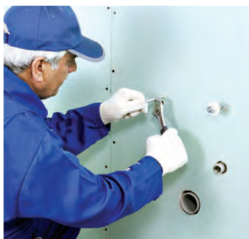
شکل ۱-۱۵۸- اتصال مهار روشویی به تراورس
