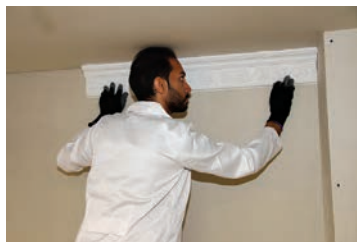
شکل ۲۴۵-۱- نصب قطعه پلی یورتان با چسب
