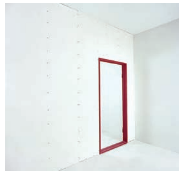
شکل ۱-۱۴۰- پانل‌گذاری در یک سمت دیوار تکمیل شده
