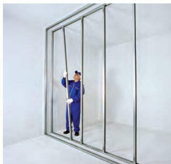
شکل ۱-۹۵- اجرای ردیف اول استادها
