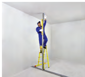
شکل ۴۶-۱- انتقال تصویر رانر کف به سقف (با استفاده از استاد و رانر)
