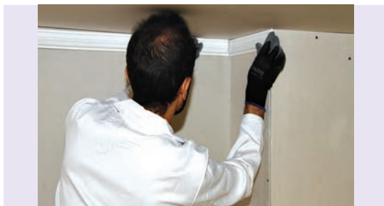
شکل ۲۳۲-۱- نصب قطعه نهایی
