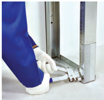
شکل ۱۱۷-۱- اتصال پایین استاد با پانچ
