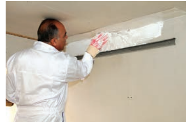
شکل ۲۳۷-۱- اجرای اندود گچ
