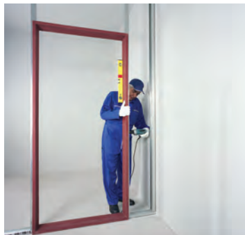
شکل ۱۲۲- اتصال بالای استاد با پیچ LB شکل ۱۲۳- اتصال چهارچوب به استاد شکل ۱۲۴- اتصال چهارچوب به استاد اول دوم
