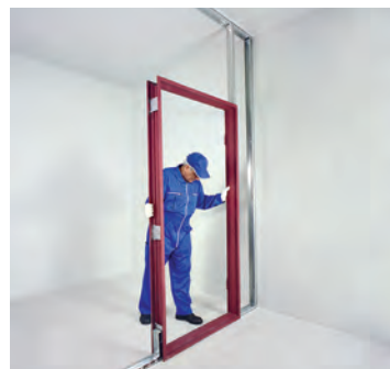
شکل ۱۱۹-۱- استقرار چهارچوب در
