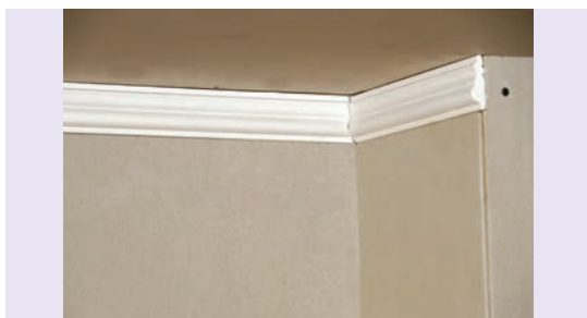
شکل ۲۳۳-۱- اتصال قطعات در کنج
