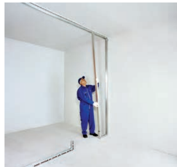
شکل ۱۱۶-۱- نصب استاد اول
