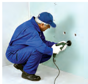
شکل ۱-۱۵۷- ایجاد خروجی‌های تأسیساتی به وسیله گردبر
