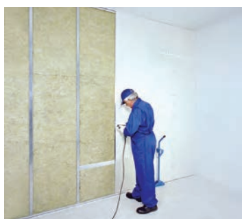
شکل ۱-۶۹- اجرای پانل‌ها در طرف دیگر دیوار
