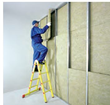
شکل ۸۷-۱- اجرای عایق پشم معدنی
