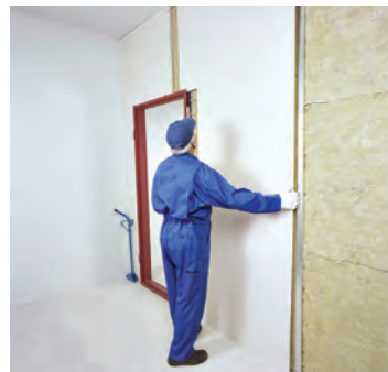
شکل ۱۴۳-۱- اجرای پانل چهارم دور چهارچوب
