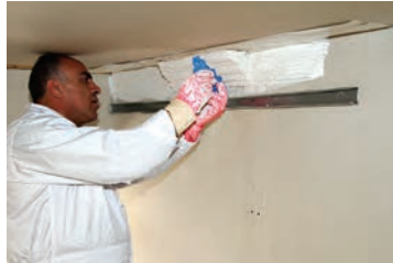
شکل ۲۳۸-۱- کشیدن ابزار
