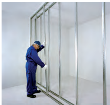
شکل ۱-۹۶- شاقولی کردن ردیف اول استادها
