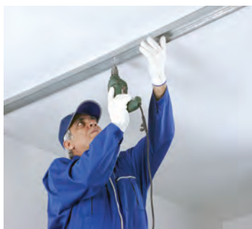
شکل ۴۸-۱- نصب رانر سقف
