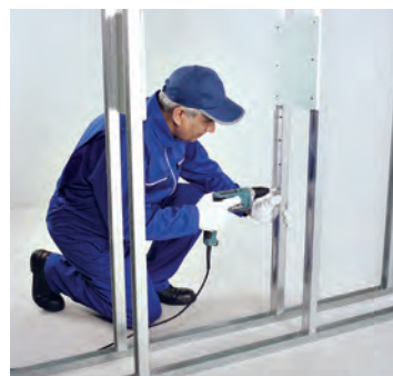
شکل ۱-۱۵۴- اتصال قطعات نشی L25 به استادهای مجاور
