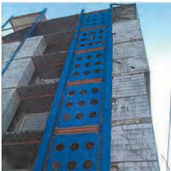
شکل ۶۱ ▲ دیوار برشی فولادی
