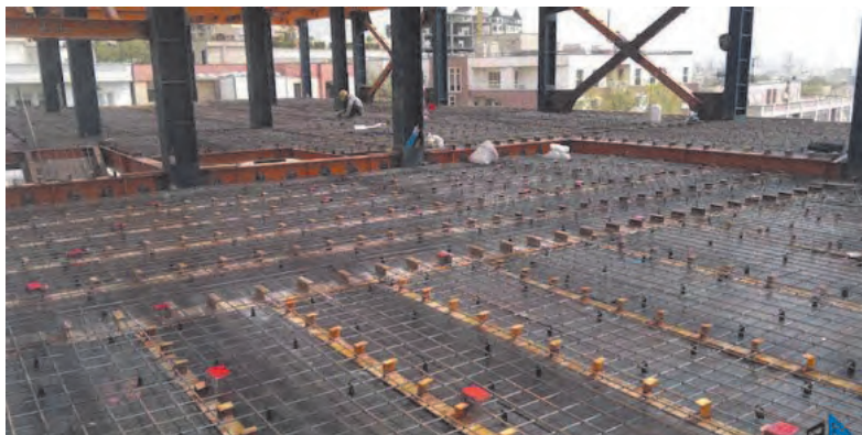
شکل ۳۲ ▲ سقف مرکب به همراه برشگیرها
