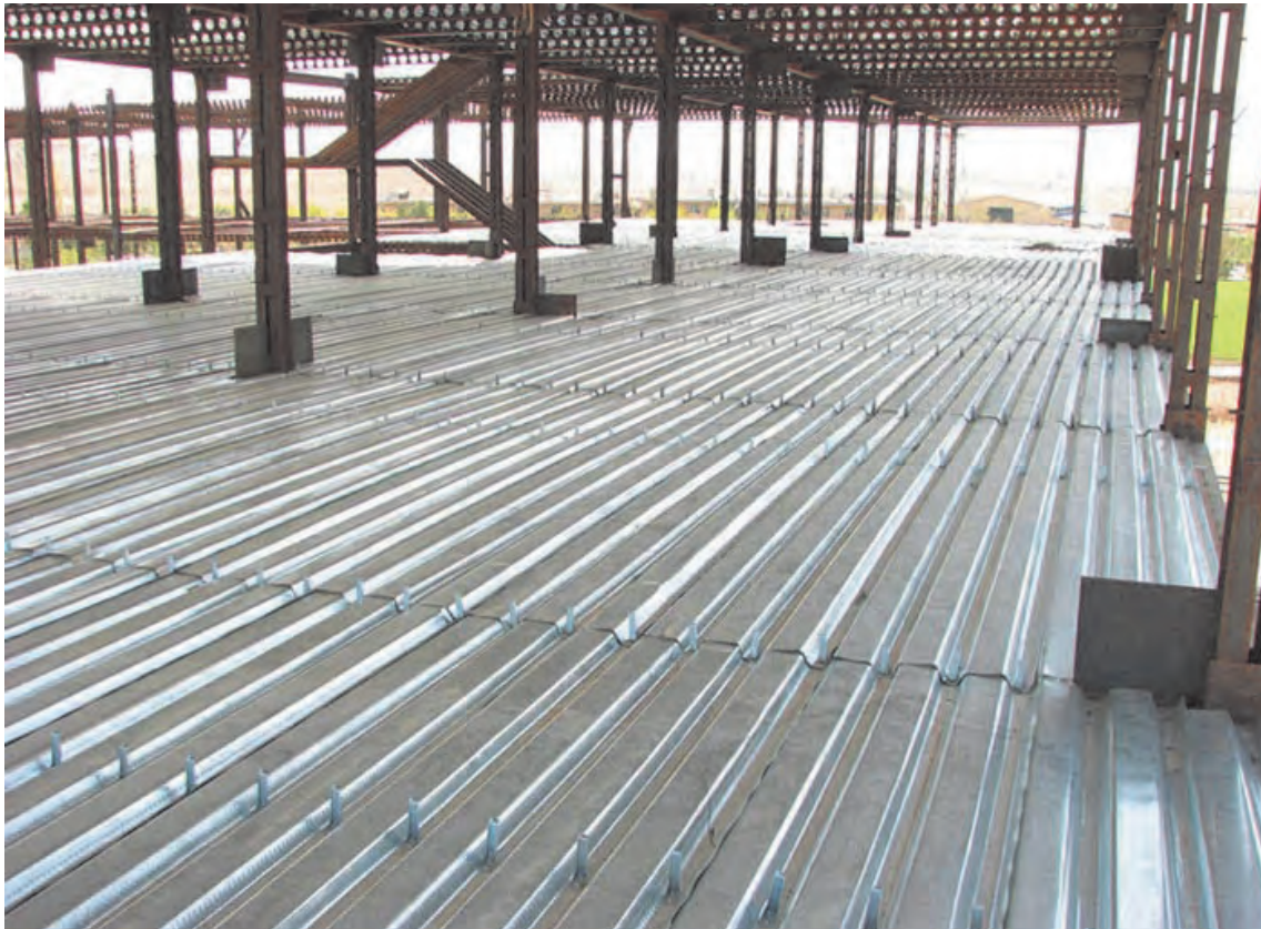
شکل ۳۳ ▲ سقف عرشه فولادی
