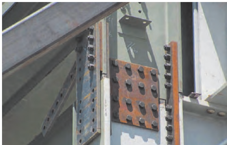
شکل ۵۷ وصله پیچی ستون
