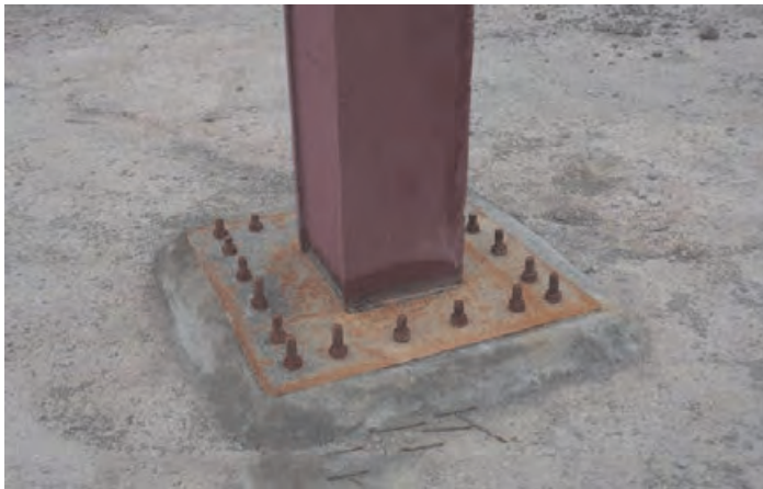
شکل ۴۹ ▲ اتصال مستقیم ستون به کف ستون
