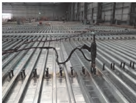
شکل ۳۴ ▲ روش نصب گل‌میخ روی سقف عرشه فولادی
