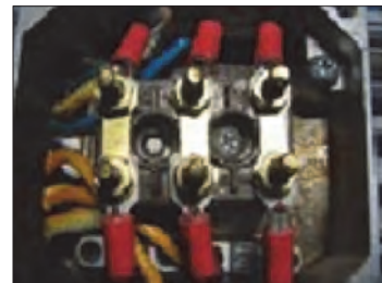
عکسی از تخته ترمینال یک موتور با اتصال مثلث
