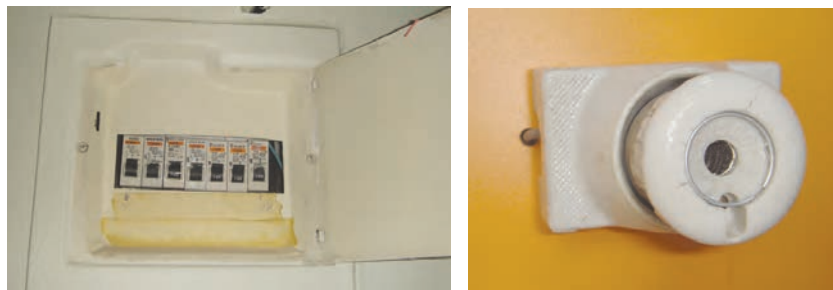
شکل ۱۳۴-۲ انواع فیوز
