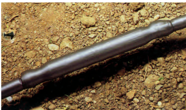
ج- وضعیت روکش پس از عملیات
