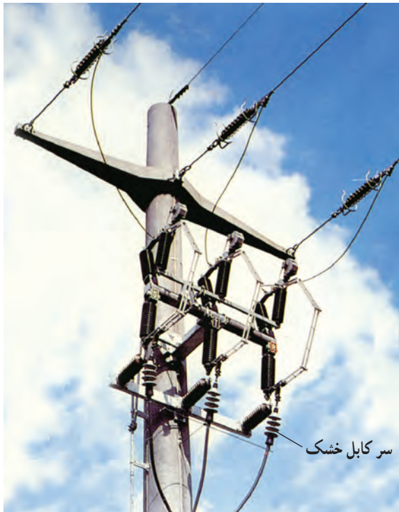
شکل ۶-۶- سر کابل خشک حرارتی هوایی
