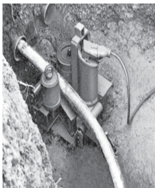
شکل ۵-۵۱- دستگاه کشش کابل
