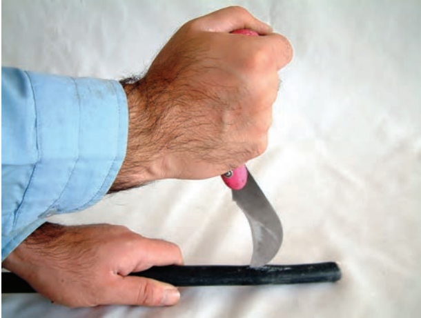
الف - نحوه‌ی غلط لخت کردن کابل
