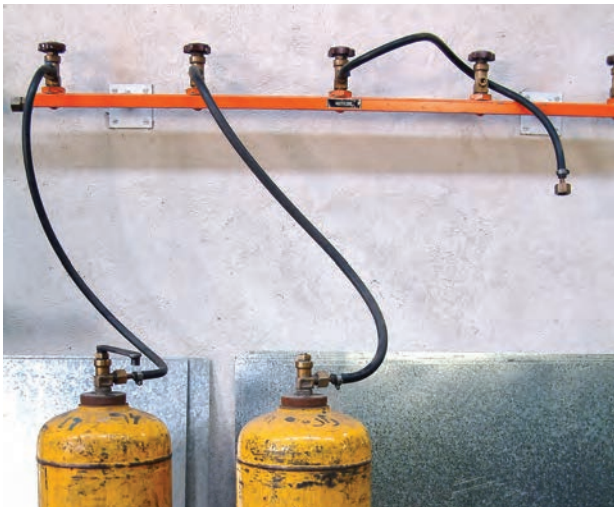
شکل ۲۵-۲- گاز استیلن از کپسول به خط لوله‌ی گاز هدایت می‌شود.
