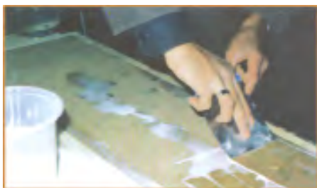
شکل ۵-۳۲. نمونه‌ی پخش کردن چسب به وسیله‌ی کاردک.
