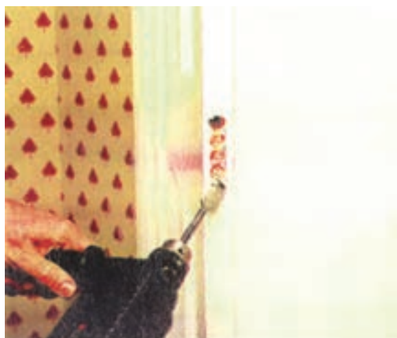
شکل ۱۰-۴۵ - تفلیه‌ی ممل قفل با دریل.
