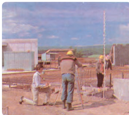
شکل ۱۴-۸ — طریقه‌ی نگاه داشتن میر
