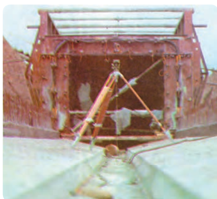
شکل ۳۰-۸- دوربین ترازباب، سانترآژ با شاقول
