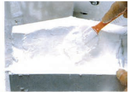
۱۶- گچ را درون قالب یک دست کنید.
