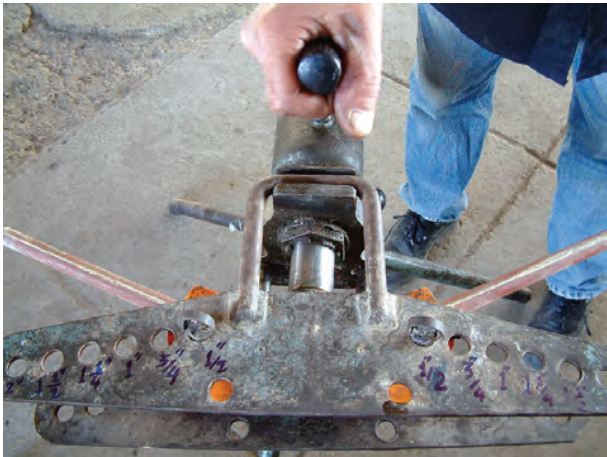
شکل ۳-۲۴- عمل خم کاری لوله های فولادی به وسیله خم کن هیدرولیکی
