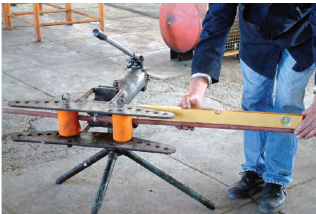
شکل ۳-۴۳- کنترل افقی بودن لوله در خم کاری
