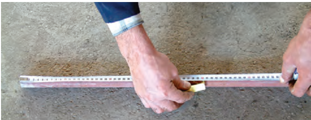
شکل ۳-۵۴- خط کشی لوله و تعیین محل‌های خم
