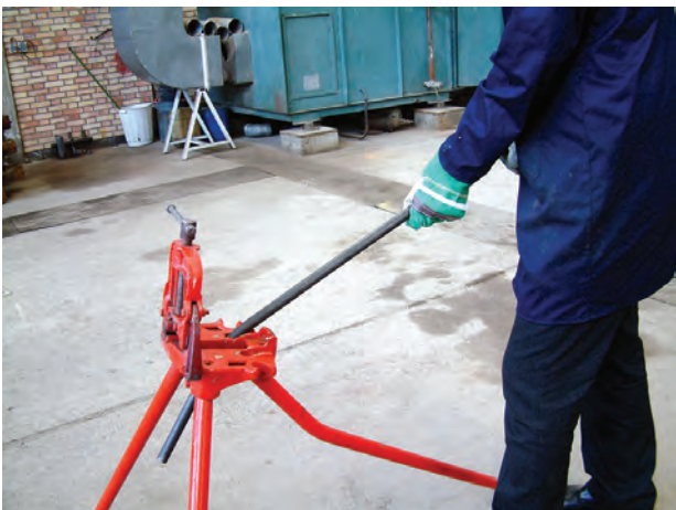
شکل ۳-۹- خم کاری لوله به وسیله‌ی گیره‌ی صحرایی
