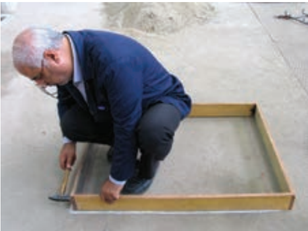
شکل ۴-۱- قالب بندی فونداسیون
