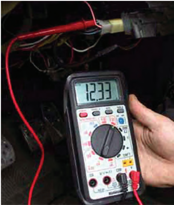
شکل ۲۸-۱۱- اندازه‌گیری ولتاژ در ترمینال ورودی سوئیچ
