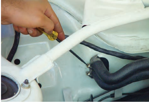
شکل ۴-۳۱- باز کردن لوله های آب رادیاتور بخاری
