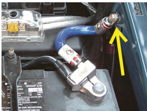
شکل ۲۴-۲ اتصال کابل منفی باتری به بدنه
