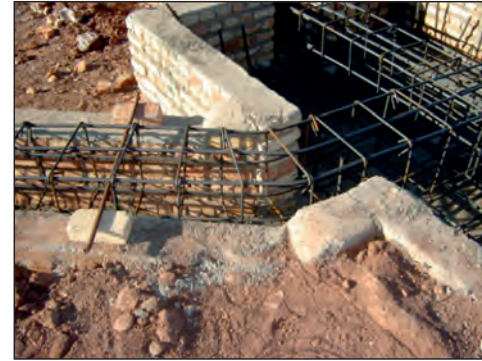
شکل ۲-۱۴۳ آرماتورهای شناژ و پی
