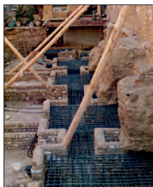
شکل ۱-۹۰ مهاربندی با شمع چوبی
