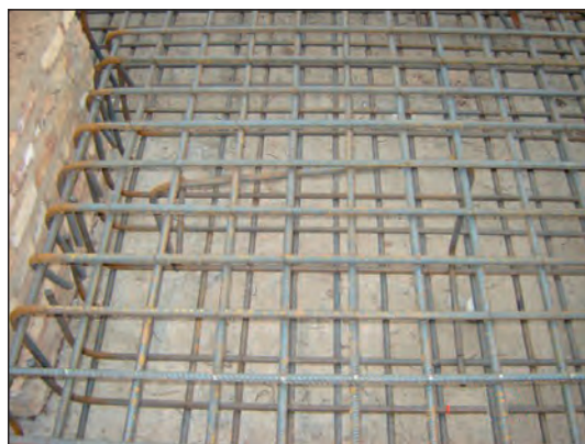
شکل ۱۴۷-۲ پی نواری و آرماتورگذاری آن
