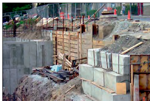
شکل ۱-۹۱ مهاربندی با دیوار مانع چوبی
