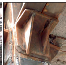
اتصال تیر به ستون به صورت لچکی
