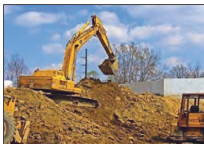
شکل ۱-۱۳- کندن زمین با وسایل مکانیکی
