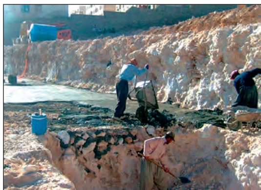
شکل ۱-۸۷ گودبرداری دستی (با بیل و کلنگ)
