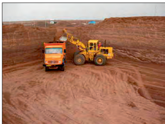
شکل ۱-۸۵ گودبرداری با لودر در زمین نامحدود
