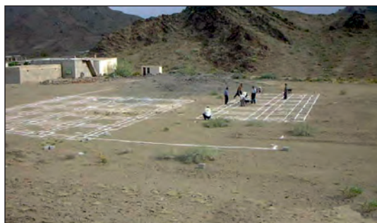
شکل ۱-۸۳ پیاده کردن نقشه روی زمین
