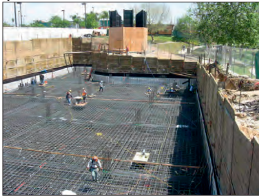
شکل ۱-۶۲ پی بتن مسلح یکپارچه (رادیه ژنرال)
