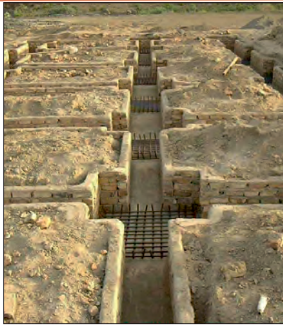
شکل ۴۸-۱ آرماتورگذاری پی تکی کلاف بندی شده
