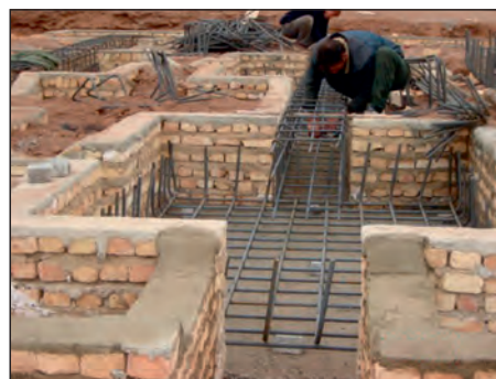
شکل ۱-۸۲ قالب‌بندی آجری در اطراف پی
