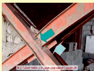
ضعیف بودن جوش و عدم اتصال مناسب
