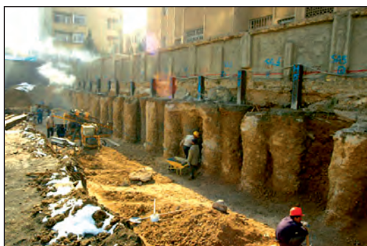
شکل ۱-۸۸ مهاربندی با پشت بند خاکی ستونی
