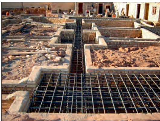
شکل ۷۰-۲ میلگردگذاری در پی کلاف بندی
