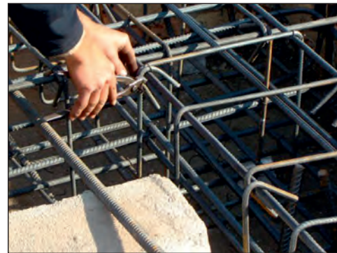
شکل ۲-۱۴۱ بستن خاموت دور آرماتور اصلی شناژ
