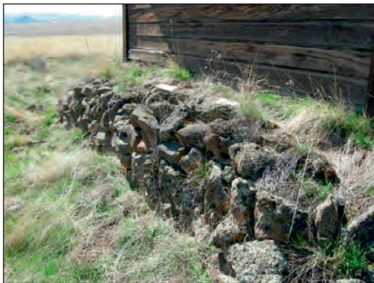
شکل ۱-۳۲ پی سنگی با سنگ لاشه
