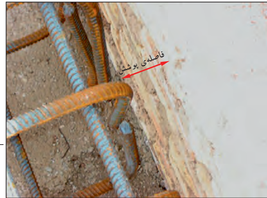
شکل ۲-۱۲۶ فاصله‌ی پوشش و قلاب سر میل‌گردها
