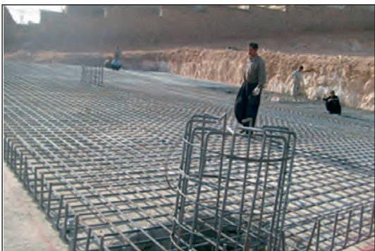
شکل ۱۵۲-۲ آرماتورگذاری پی صفحه‌ای با ستون‌های بتنی
