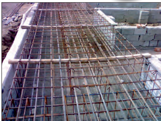
شکل ۱۴۶-۲ پی نواری و آرماتورگذاری آن
