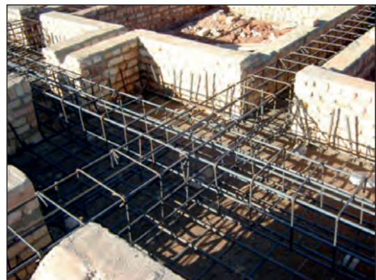
شکل ۷۱-۲ عبور میلگردهای شناژ در پی
