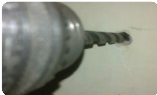
شکل ۶-۶ - سوراخکاری دیوار با مته الماسه مناسب
