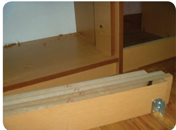
شکل ۱۶۶-۵- نصب پاسنگ با استفاده از گونیای فلزی
