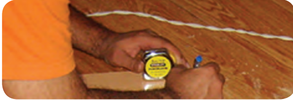
شکل ۵-۱۲۳- علامت‌گذاری و تعیین محل سوراخ‌ها
