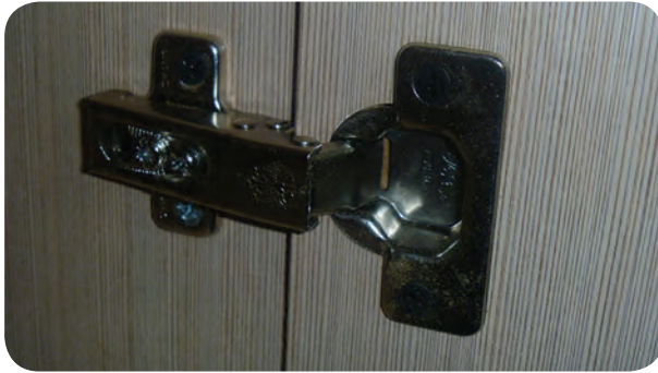
شکل ۵-۱۶۳- نصب لولای گازی فنردار به در کمد
