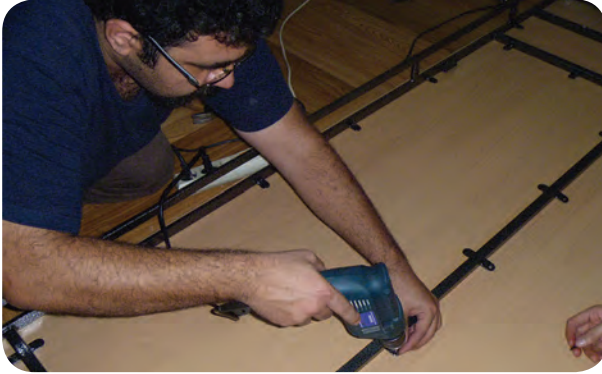
شکل ۱۳۲-۵- محکم کردن کلاف فلزی به پشت در تختخواب
