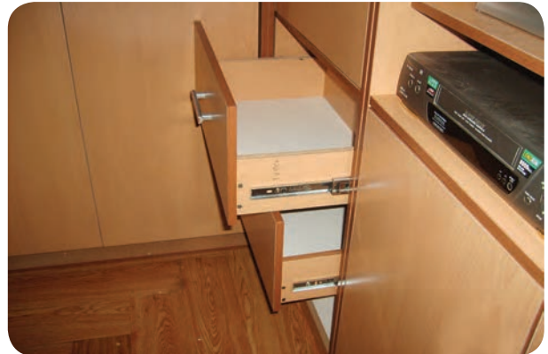
شکل ۱۷۷-۵- نصب کشویی تلسکوپی سه ریله برای کشو
