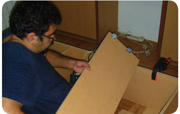
شکل ۵-۱۶۱- نصب طبقات به وسیله گونیاها فلزی
