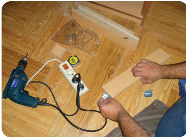
شکل ۱۷۹-۵- آماده کردن پاسنگ‌ها
