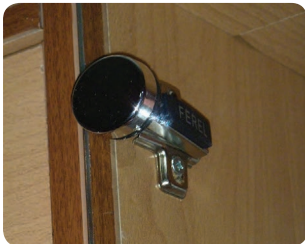
شکل ۱۴۴-۵- استفاده از واشر پلاستیکی بین کار، لولا و شیشه
