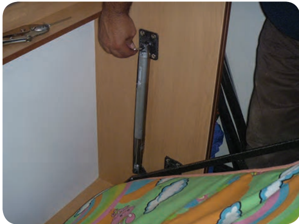
شکل ۵-۱۳۷ تنظیم فشار گاز سیلندر برای تعادل تختخواب
