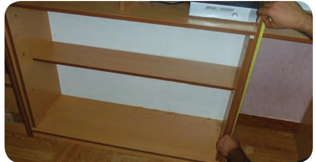
شکل ۱۷۳-۵- اندازه‌گیری برای نصب صفحه زیر کشوها
