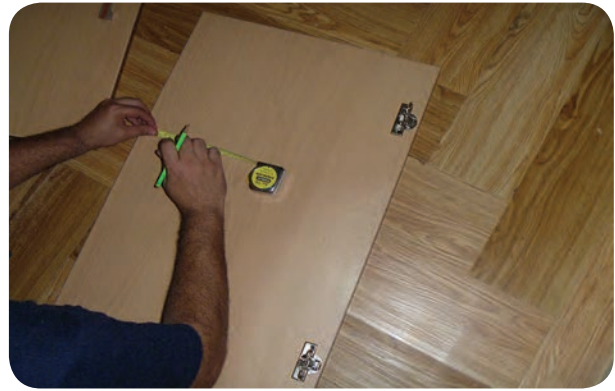
شکل ۱۵۰-۵- نصب لولای در کمد
