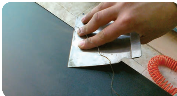
شکل ۲۵-۴ - نحوه برطرف کردن اضافه نوار با لیسسه
