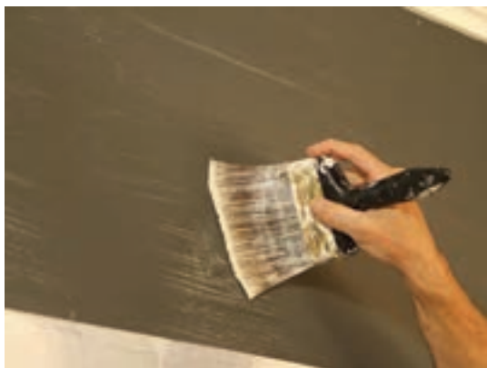
شکل ۸۴- چسب زدن دیوار
