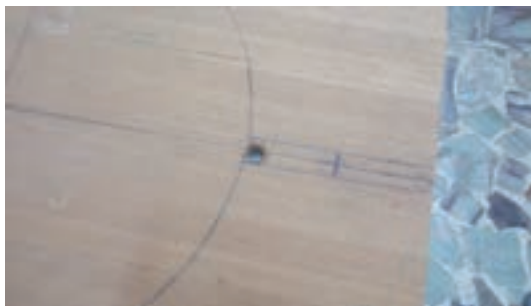
شکل ۵۸- سوراخ کاری برای قرار گرفتن تیغه
