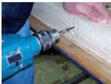
شکل ۵۸- بستن پیچ در حالت افقی
