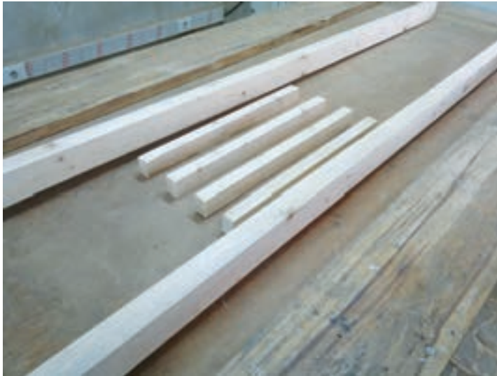
شکل ۳۹- قطعات پاراوان (۲ قید طولی و ۴ قید عرضی)
