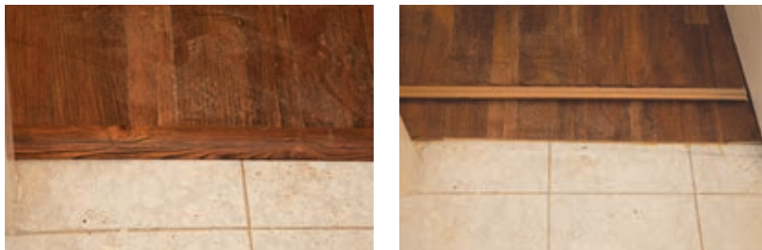
شکل ۸۲ و ۸۳ - پشت و روی پروفیل آستانه
