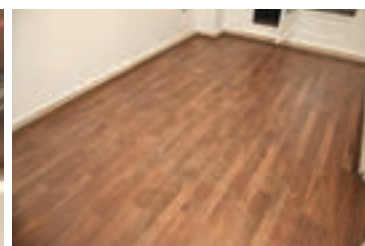
شکل ۹۵ تا ۹۹ - مراحل نصب و میخ زدن قرنیز و پوشش نهایی کف پوش
