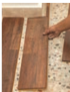
شکل ۹۰ و ۹۱ - قفل کردن قطعات لمینت به یکدیگر
