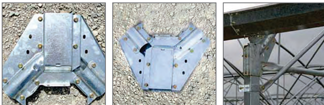
شکل ۷- اجزای اتصالات گلخانه
