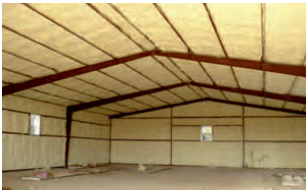
عایق‌بندی سقف و دیواره
