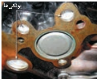
پولکی‌های نصب شده
