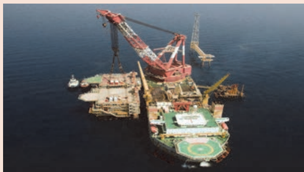
عملیات نصب سکوی فاز ۱۹ پارس جنوبی در خلیج همیشه فارس با به‌کارگیری از یکی از مدرن‌ترین شناورهای نصاب منطقه (اوشنیک ۵۰۰۰)
