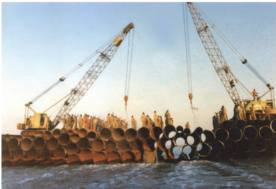
شکل ۱۱-۵- پل بعثت در حال ساخت
