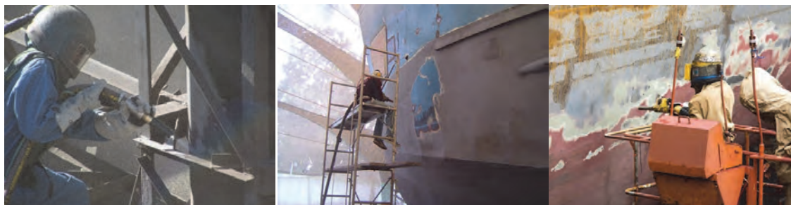
شکل ۱-۷ زنگ‌زدایی در اسکله خشک
