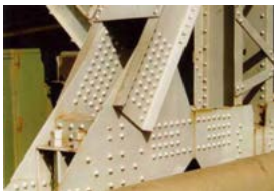
الف) شکل ۳-۱۸ سازه فلزی اتصال پرچی
