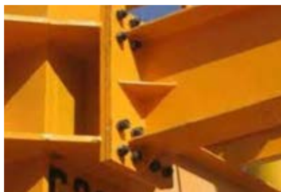
ب) شکل ۳-۱۸ سازه فلزی اتصال پیچ و مهره
