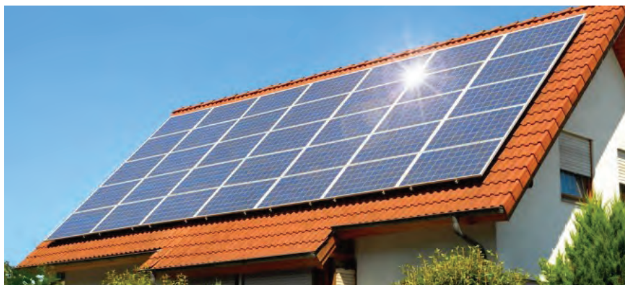
تصویر ۸ - نمونه ای از نصب آرایه های فتوولتائیک بر روی سطح بام شیب دار
